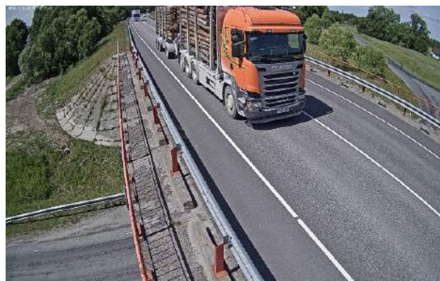
▲ Foto 2 | 2018. a Sanga viaduktil iBWIMi mõõtmiste käigus fikseeritud veok tegeliku massiga 82,8 t [8]
