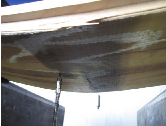
Foto 12. Põrandalaua F3.2 purunemispilt
