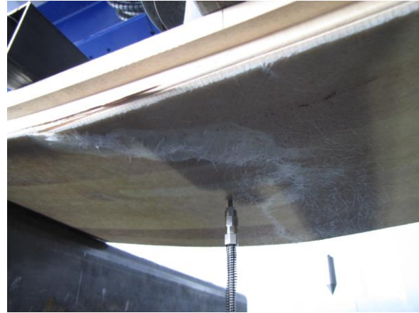
Foto 13. Põrandalaua F4.2 purunemispilt
