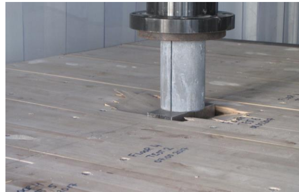
Foto 9. Põrand 1 purustav katse
