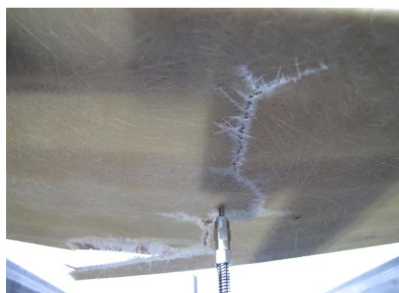
Foto 11. Põrandalaua F2.2 purunemispilt
